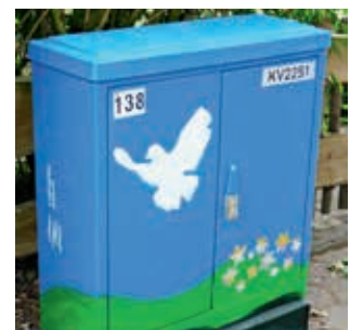
Neugestaltung einer Erkrather Trafostation mit Hilfe eines Graffitis
