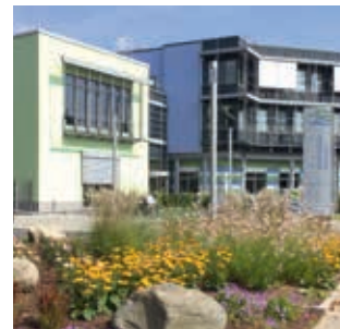
Die Energiekosten am Stadtwerke-Gebäude konnten dank energetischer Sanierung gesenkt werden.
