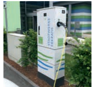
Förderung von E-Mobilität: Erschließung der Ladeinfrastruktur in Erkrath
