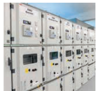
Erneuerung der Schaltanlage in der Umspannanlage an der Bachstraße
