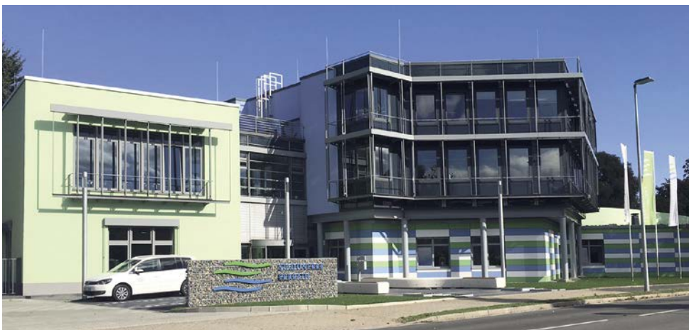
Sitz der Stadtwerke Erkrath an der Gruitener Straße. Von hier aus werden Hochdahl und Unterfeldhaus energieeffizient mit Trinkwasser versorgt.
